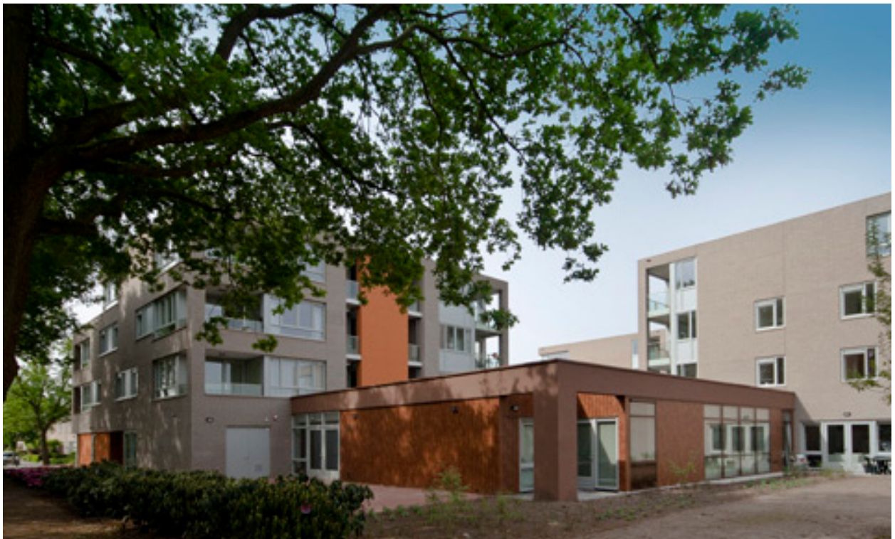
Abbildung 10: Überbauung Jo van Dijkhof, Nuenen
