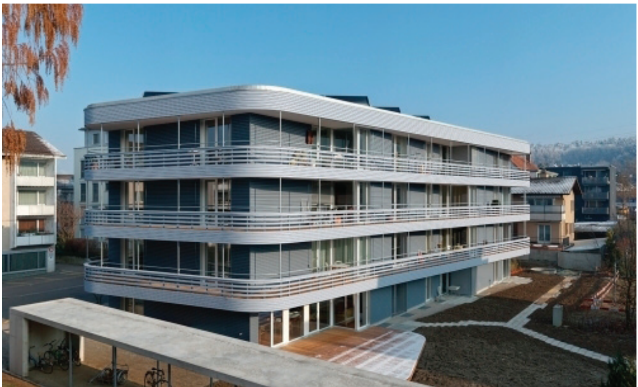
Abbildung 18: Ansicht Kanzleistrasse 50, Winterthur-Seen
